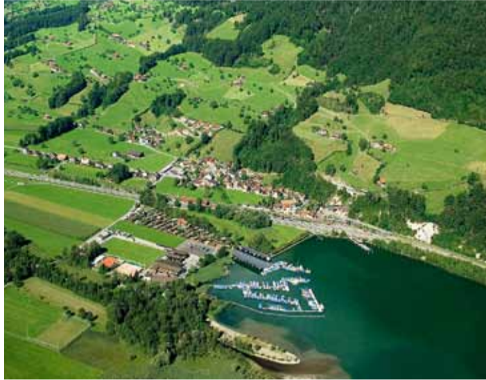
Herzog Marinecenter AG: Der Hauptsitz in Alpnachstad wird umgebaut.
